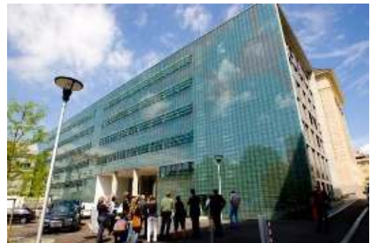
Die Neue Chemie am Campus Neue Technik der TU Graz. © Lunghammer - TU Graz
